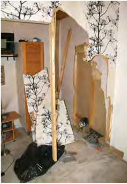
Lastulevyn pinta on saanut kosteutta. Kosmeettisista syistä myös vahingoittumattomia lastulevyjä vaihdettiin gyprok- eli kipsilevyihin.
